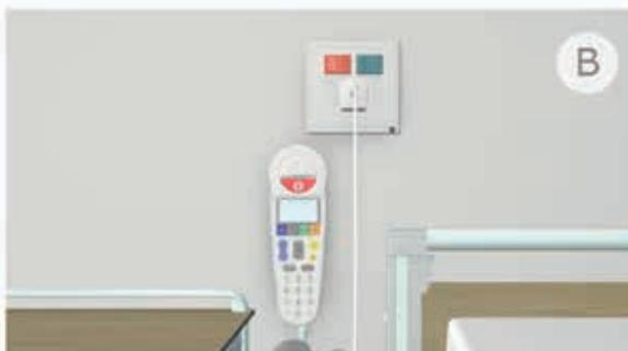
Module mural LAN et terminal patient portatif intégré avec fonctions de commande, de téléphonie et de facturation. En option, traitement des appels par terminaux DECT mobiles.
